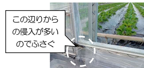
写真6 隙間をふさいだ出入口付近
